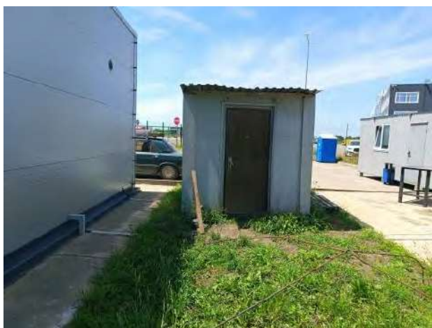
Фото № 19. Насосная станция наружного пожаротушения (НСПТ)
