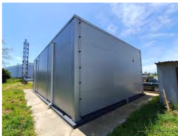
Фото № 20. Насосная станция наружного пожаротушения (НСПТ)
